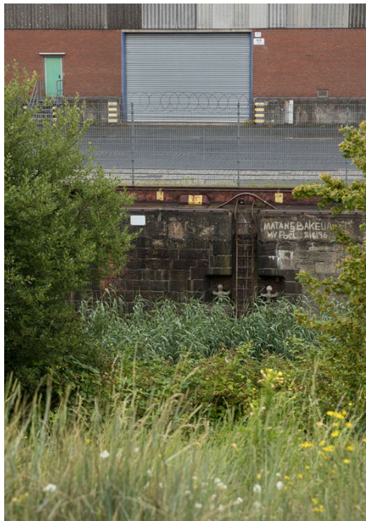
An der alten Kajenmauer finden sich heute noch Schriftzüge der Hafentarbeiter, die hier früher gearbeitet haben
